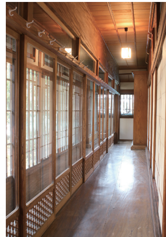
③ 1階縁側。長さ12.3mのケヤキの梁と2枚組合せの床板が圧巻。
